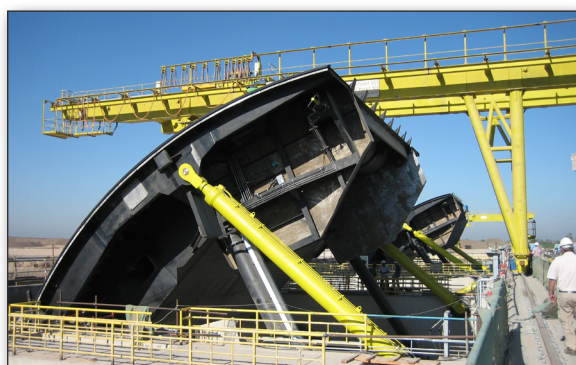
Wehranlage und Schleuse in Naga Hammadi, Ägypten Bildquelle: DSD NOELL
