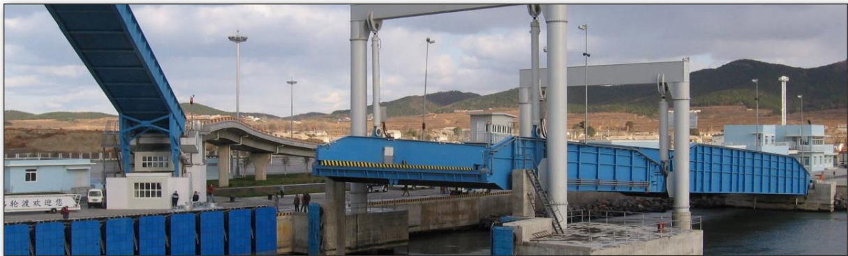
Fähranleger in Yantai-Dalian, China Bildquelle: DSD NOELL
