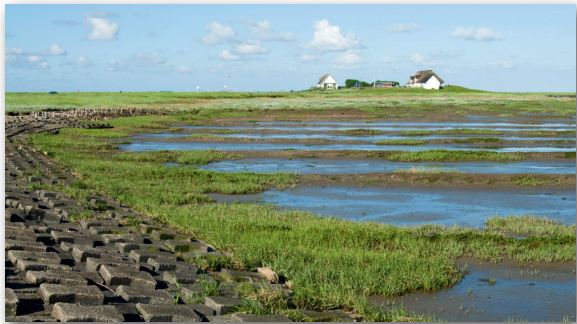
Küstenbefestigung an der Hamburger Hallig (Bildquelle: Leander Khiei/LKN.SH)
